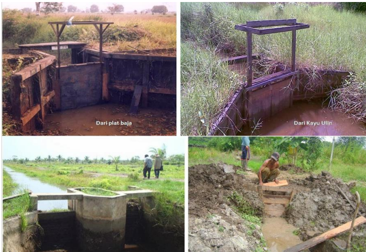
Gambar 7.7. Sistem tabat yang digunakan untuk mengatur tata air gambut
