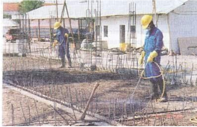
Gambar 25. Penyemprotan permukaan tanah yang akan ditutupi lantai dengan termisida
