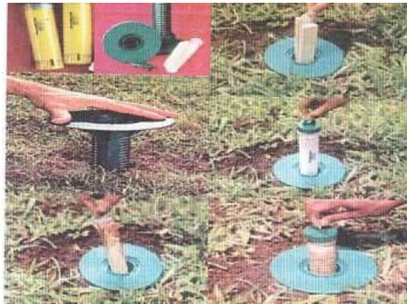
Gambar 28. Aplikasi tabung umpan rayap di sekitar bangunan
